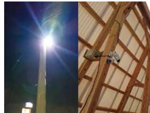
LED 街灯と防犯カメラを設置しました。
