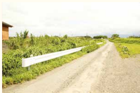
ガードレール設置の例
