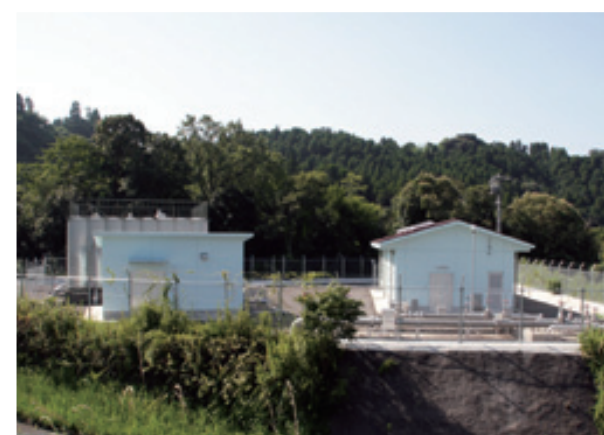
新たに供用開始された森山水源の浄水施設
