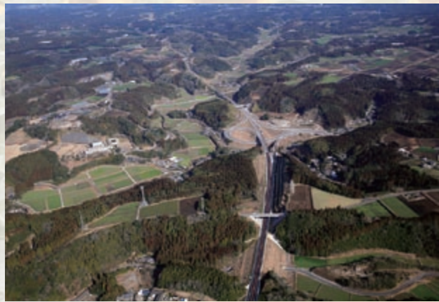
工事が進められている高規格道路
