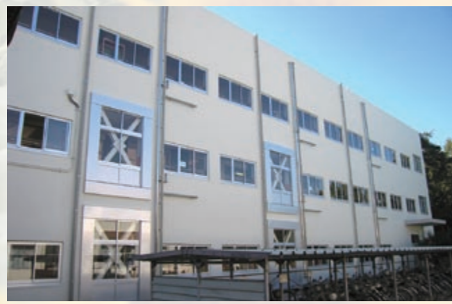
耐震化工事を行った志布志中学校
