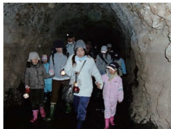
ツルハシで岩盤を掘り進んだ跡の残るトンネル
