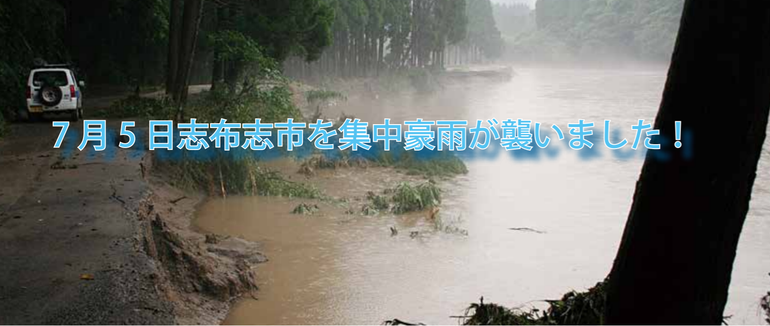
菱田川は記録的な豪雨により川が氾濫し川沿いの林と道路が流されました（有明地区蓬原）
