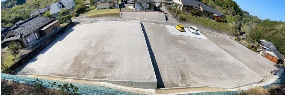
新橋定住促進住宅用地の外観
