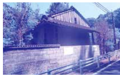
事業を活用して撤去された廃屋
