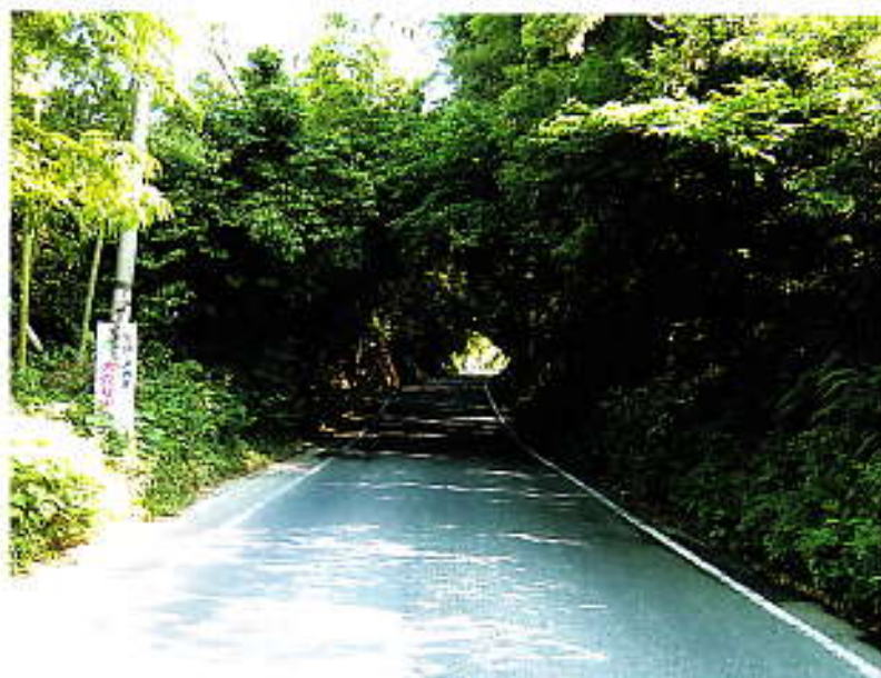
県道柿木・志布志線の現況
