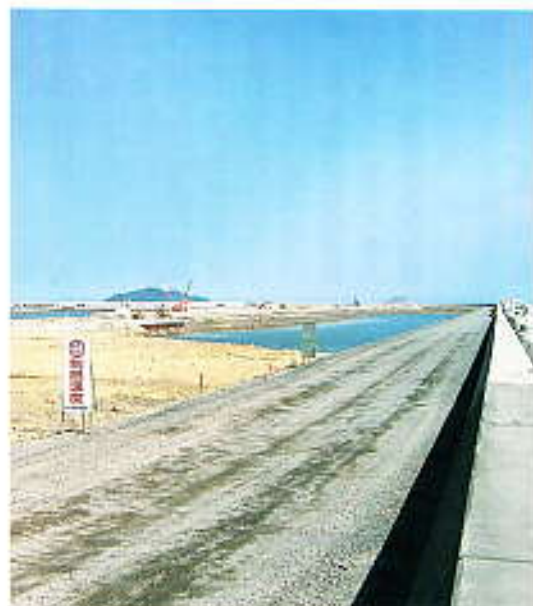
埋め立てが進む新志布志港
