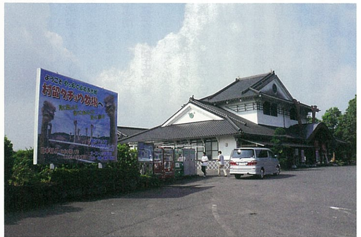
リニューアルオープンした道の駅松山ダチヨウ牧場
