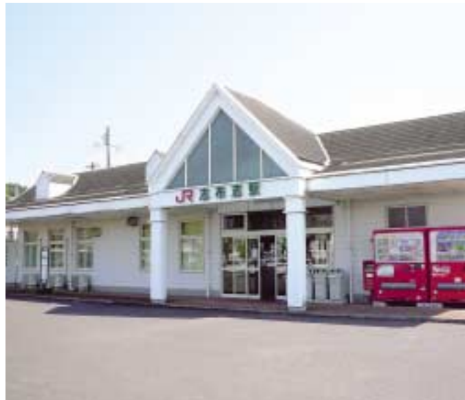
総合観光案内所設置予定の志布志駅
