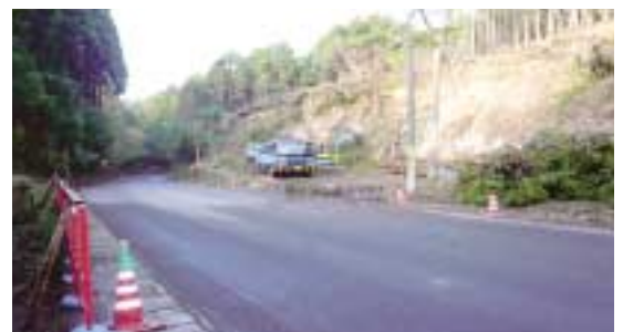
整備が進む県道柿ノ木志布志線
