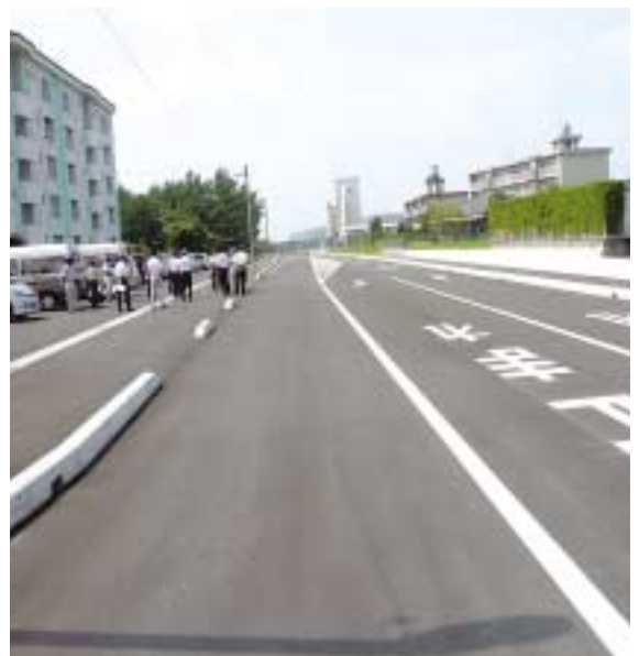
新たに伸びた市道香月線の現地調査
