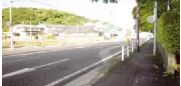
北側歩道の工事と南側歩道の現状
