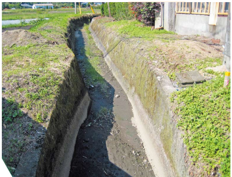
水路（青線）の状況
