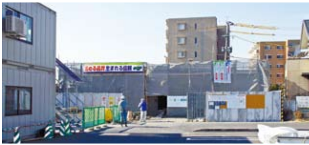
建設中の情報センター（アピア前の駐輪駐車場隣）
