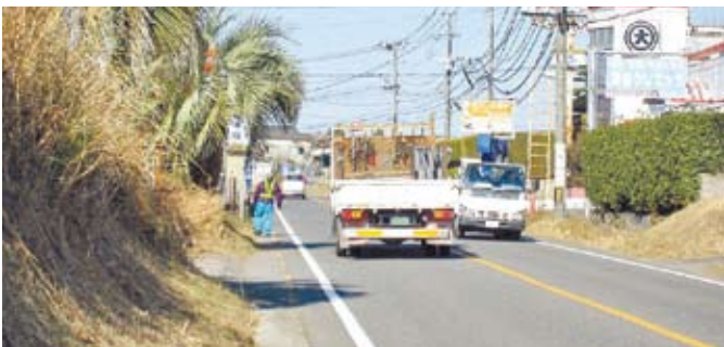
県道関屋線の歩道を改良
