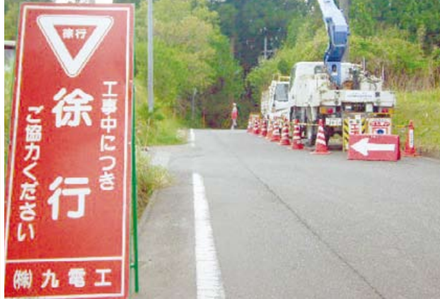
市内各地で始まった光ケーブルの敷設作業
