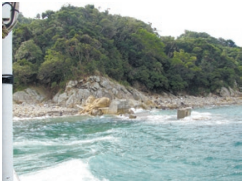
崩壊した枇榔島の栈橋
