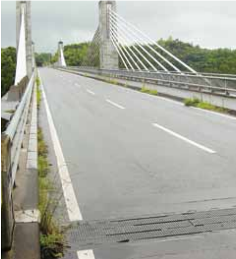
野井倉大橋の現況
