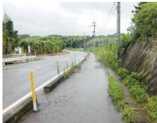
野井倉大橋付近の現状
