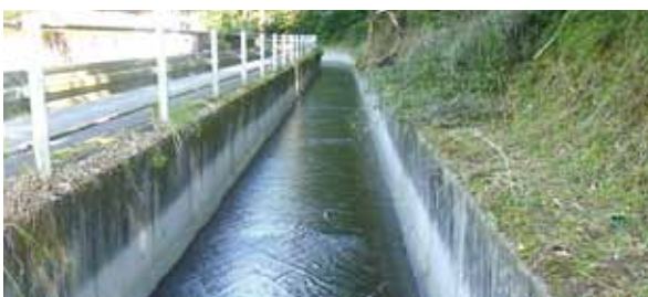
稲付川改修部分
