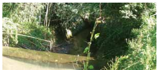
稲付川未改修部分
