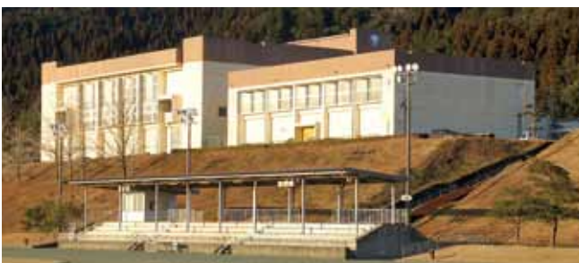
有明体育施設
