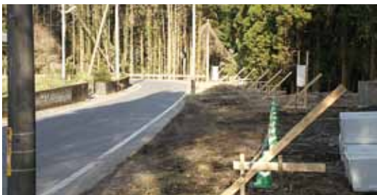
3号線の局部改良工事
