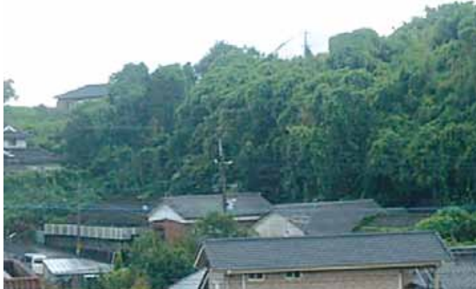
県単急傾斜崩壊対策事業(山ノ神地区)施工前
