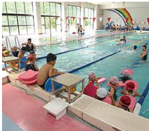
改修される 志布志運動公園屋内温水プール
