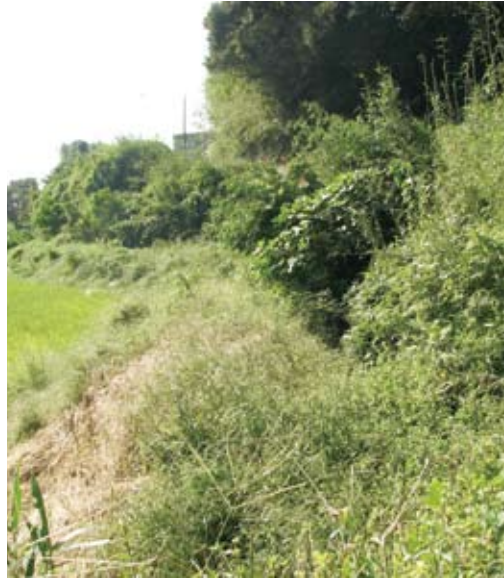
安楽土地改良区の土水路
