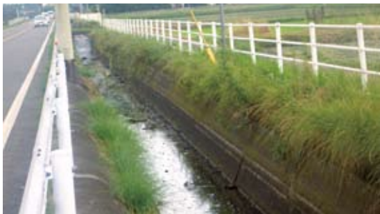
大雨時には水かさが増す用水路
