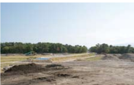
工業団地埋立て工事
