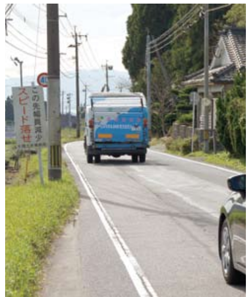
改良工事が待たれる県道志布志有明線
