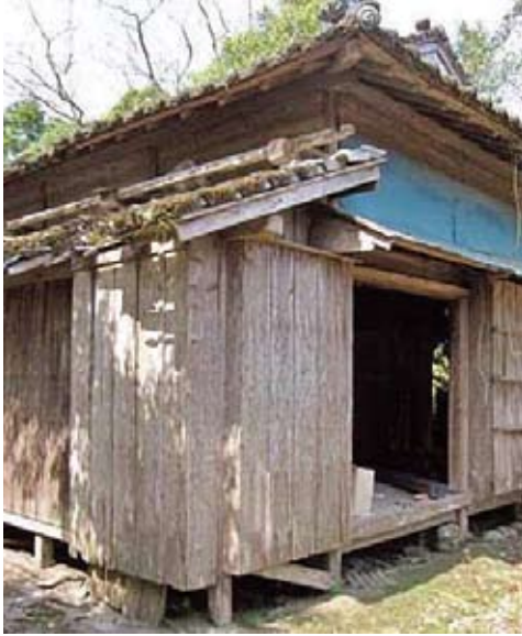
危険廃屋解体撤去補助対象物件
