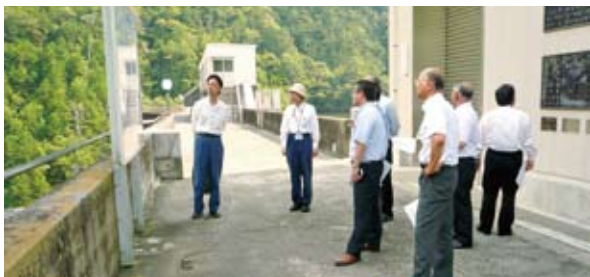
宇連ダムでの現地調査
