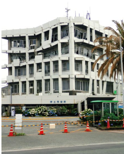
熊本地震で被災した宇土市役所
