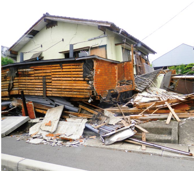
熊本地震による被災状況
