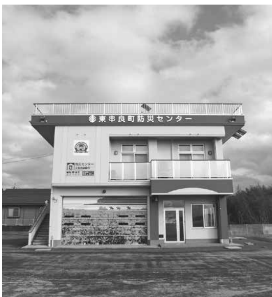
東串良町防災センター
