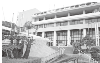
志布志支所庁舎
