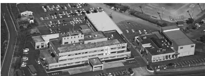
市役所本庁舎全景
