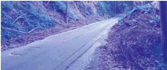
市道の法面崩壊箇所
