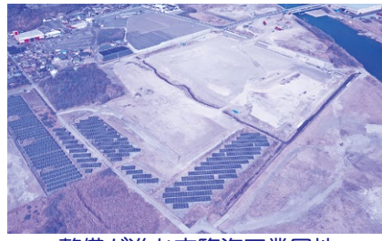
整備が進む市臨海工業団地
