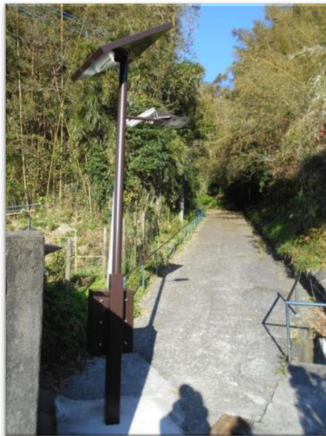
写真 2-11 ソーラーライト設置(避難経路)
