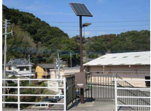
写真 2-10 ソーラーライト設置(避難階段)
