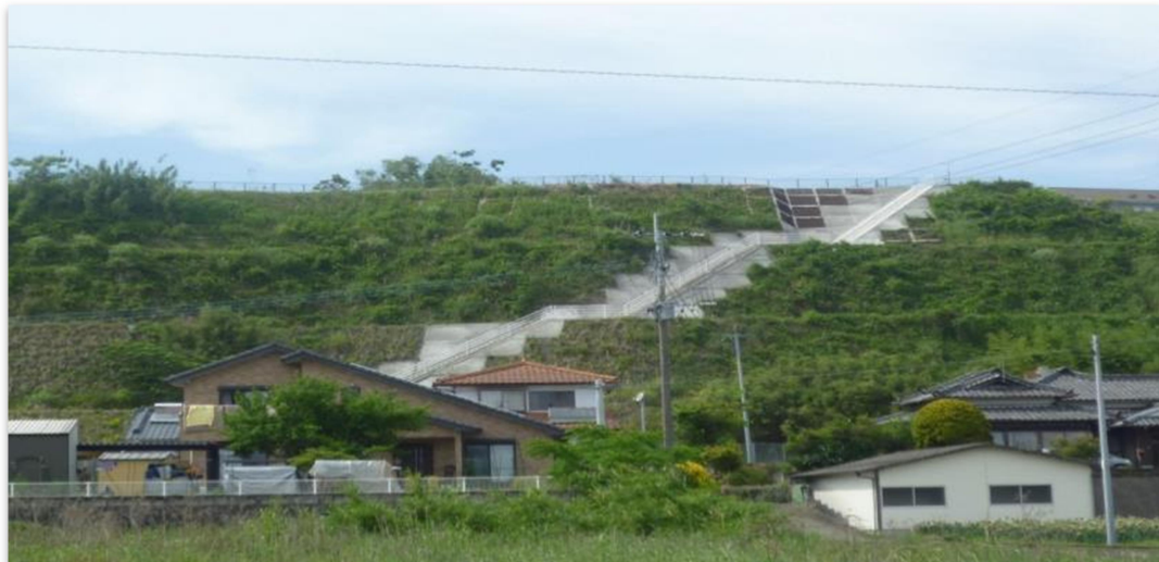
写真 2-1 2 避難階段整備
