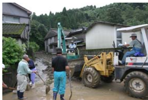
■資機材による宅地内の土砂除去
