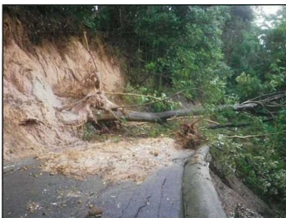
集中豪雨により道路に流出した土砂・倒木を除去して機能回復を図る
