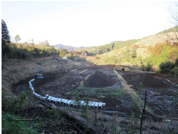
施工中のほ場
