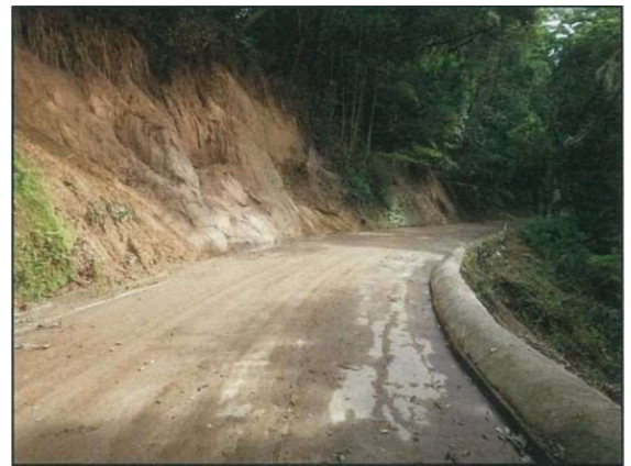
集中豪雨により道路に流出した土砂・倒木を除去して機能回復を図る
