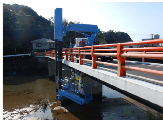
橋りょう定期点検状況
