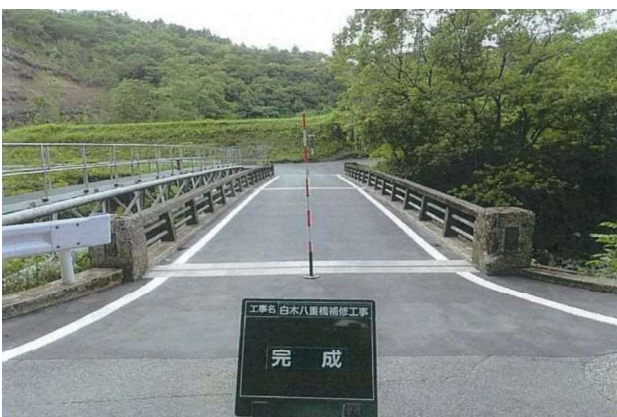
補修工事を実施した白木八重橋（志布志町）
