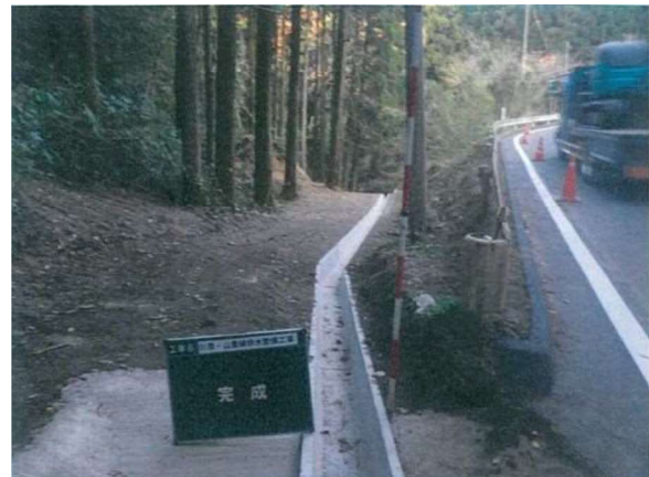
排水整備対策（水路）実施状況
