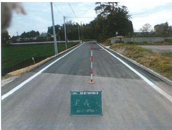
排水整備対策（舗装）実施状況
