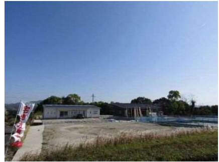
尾野見定住促進住宅用地の外観
