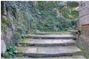
岩盤壁面と通路
