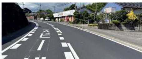
道路整備（舗装）実施状況
