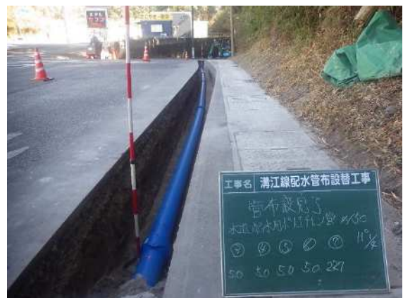
新たに布設した水道管
