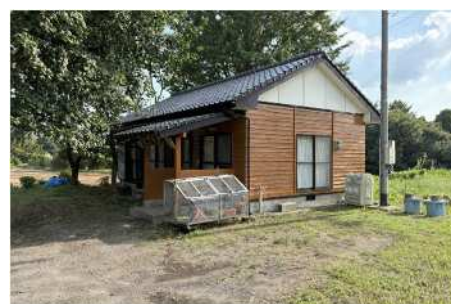
修繕後の自治会集会施設
