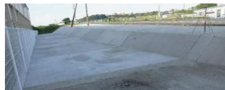
メンテナンスフリー工事实施状況
