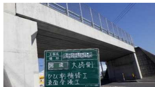
稚子松跨道橋 補修後
