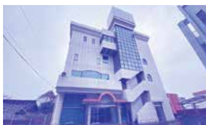
改修する旧ひばりビル
