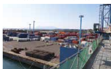
▲海に設置する前のケーソンはこんなに高さがあるんです
