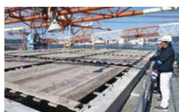
▲階段をひたすら上がりたどり着いた製作中のケーソン最上部
