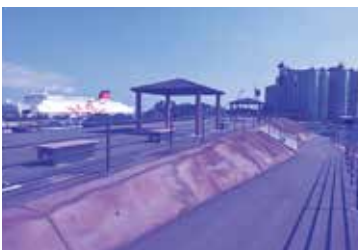
県が整備した築山（若浜地区）
