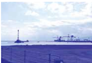
整備が進む新若浜地区
