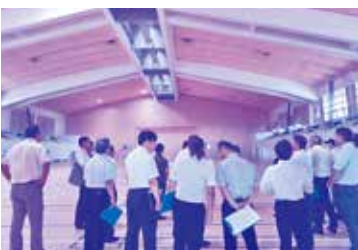
志布志運動公園体育館の現地調査
