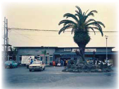
▲昭和62年当時の志布志駅舎(2代目)
