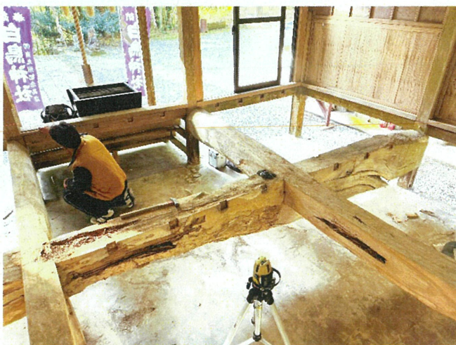
シロアリ駆除後の拝殿工事の様子
