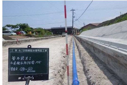
新たに布設した水道管
