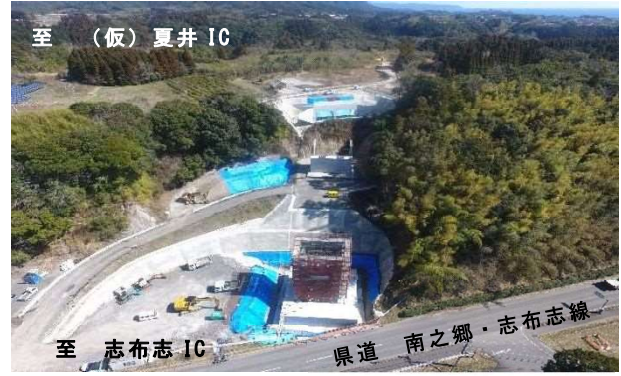
中尾橋下部工箇所
