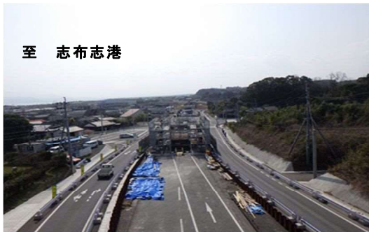
志布志道路区間橋梁工箇所
