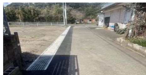
排水整備（水路）実施状況
