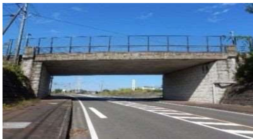
補修工事予定の大原跨道橋（志布志町）
