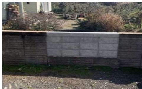
浸水箇所の閉塞
