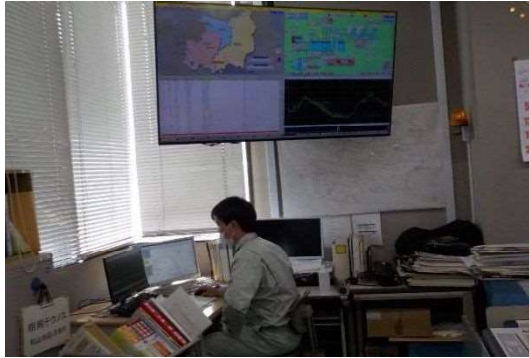
水道施設監視システムにより各水源地・配水池の異常などを常に監視
