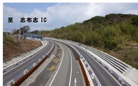
志布志道路区間改良工箇所
