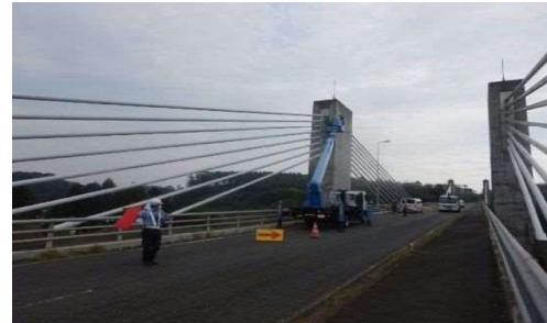
橋りょう定期点検状況
