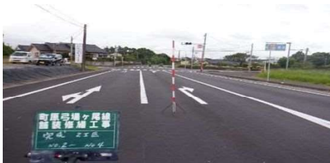
道路整備（舗装）実施状況
