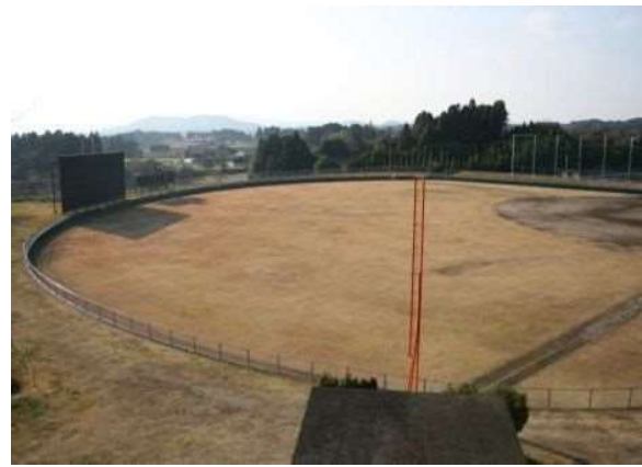
ラバーフェンスを設置予定の有明野球場
