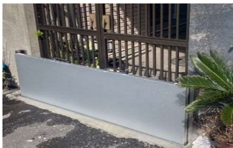
止水板の設置
