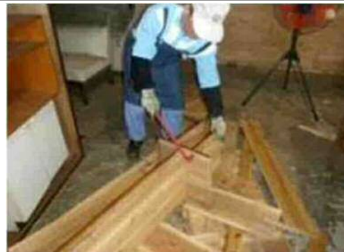
資源化するための分解作業風景
